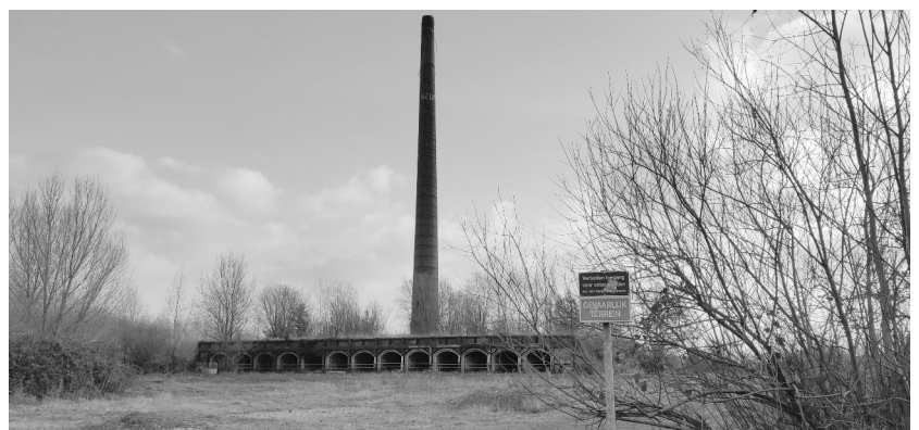
De steenfabriek uit Gevaar rond de steenfabriek nu (Heufferrein in Vuren bij de Waal)
