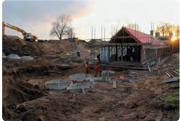
De vijf bezinkbakken onder het terras van het restaurant
