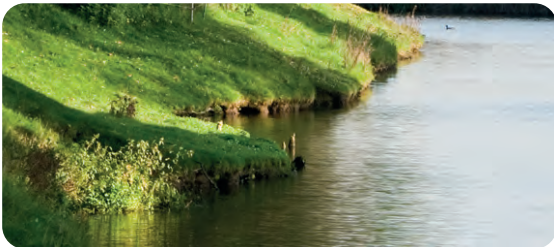
Huidige situatie, waarbij te zien is hoe de oever is afgekalfd.
