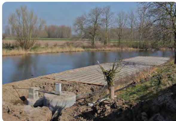
Boven: fort in 2010 zonder helofytenfilter Onder: de aanleg van het filter in 2011
